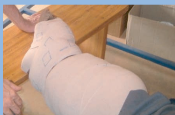
FIGURE 6 : Pose de la cinquième bande !
