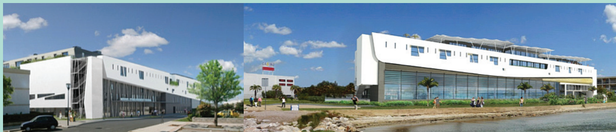
FIGURE 1 : Nouvel établissement thermal de Balaruc-les-Bains.
