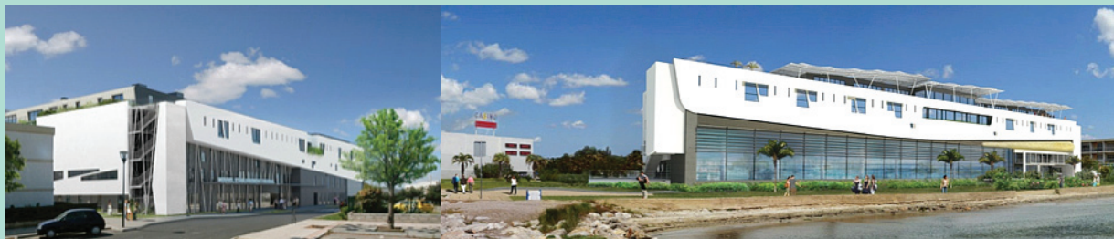
FIGURE 1 : Nouvel établissement thermal de Balaruc-les-Bains.
