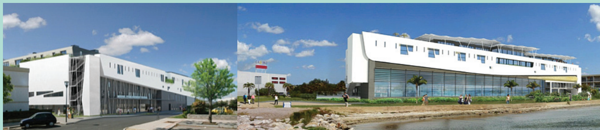
FIGURE 1 : Nouvel établissement thermal de Balaruc-les-Bains.
