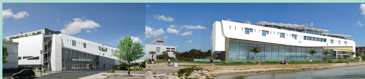
FIGURE 1 : Nouvel établissement thermal de Balaruc-les-Bains.
