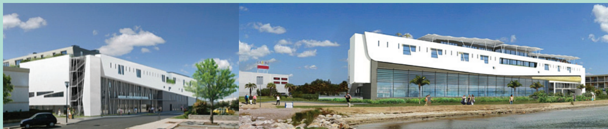
FIGURE 1 : Nouvel établissement thermal de Balaruc-les-Bains.
