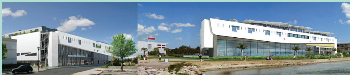
FIGURE 1 : Nouvel établissement thermal de Balaruc-les-Bains.
