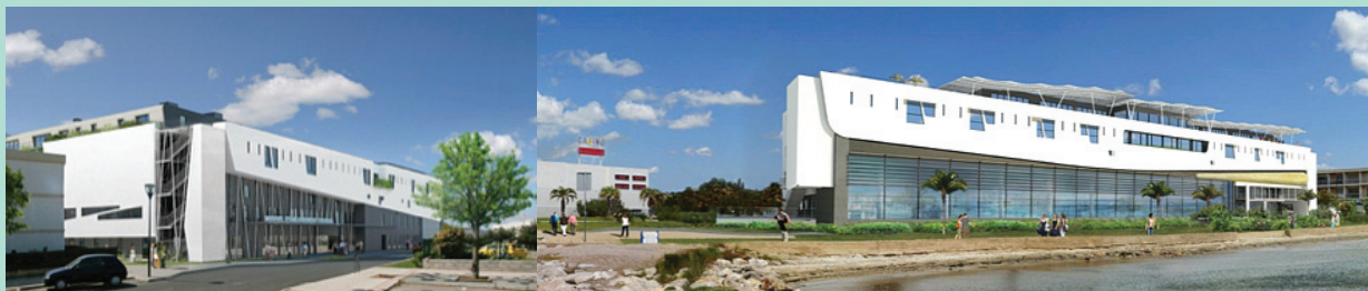
FIGURE 1 : Nouvel établissement thermal de Balaruc-les-Bains.
